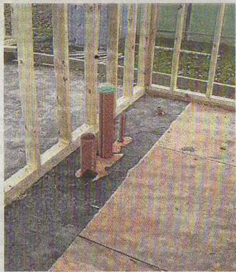
Instalaciones. Tendido bajo plataforma.
