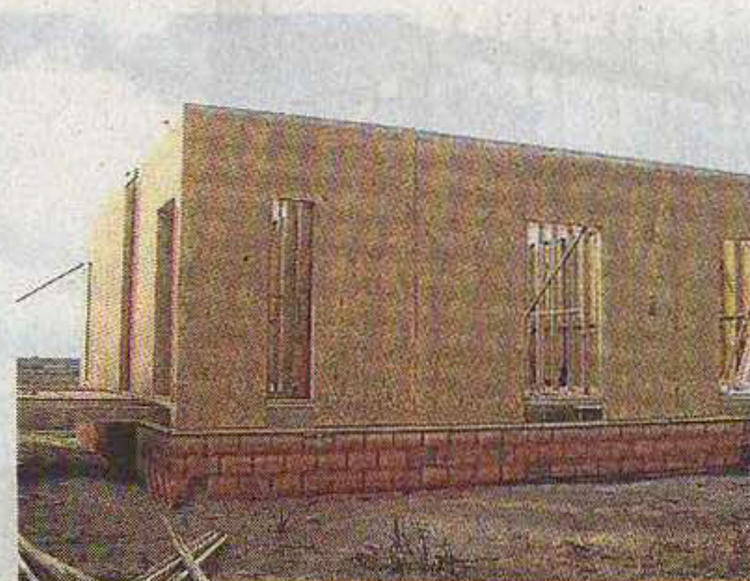
OSB. Los paneles se fijaron en sentido vertical.
