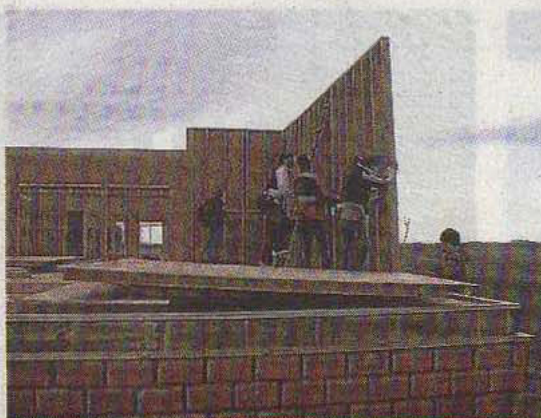
Base. La plataforma se elevó del suelo.
