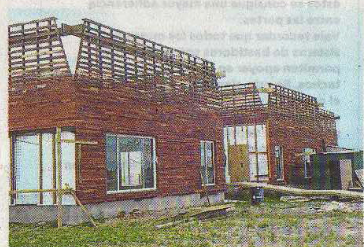
Lineal. Los listones se separan para conformar el remate.
