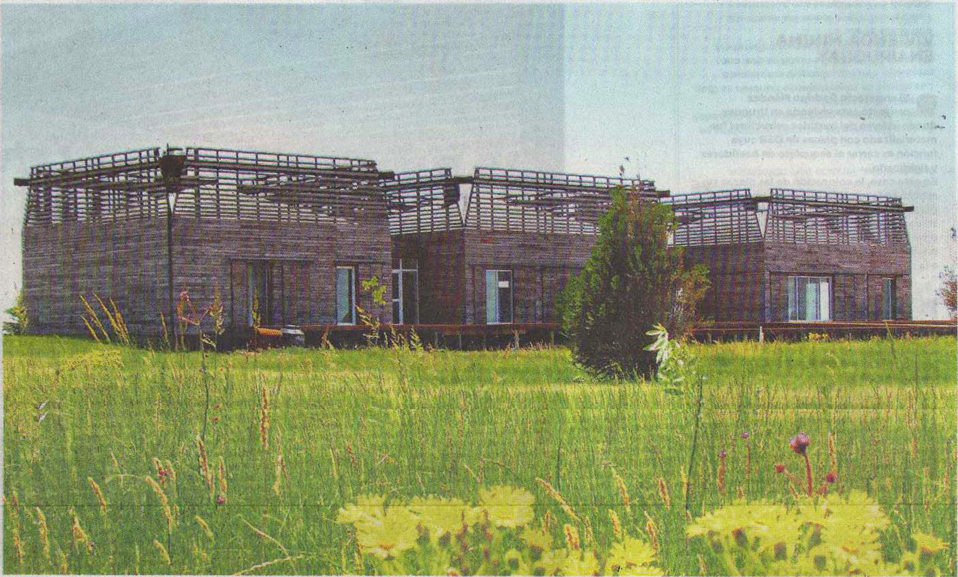
Al natural. La madera de quebracho del revestimiento no tiene tratamiento ni pintura, por lo que se "oxidó" contrayendo un tono grisáceo.
