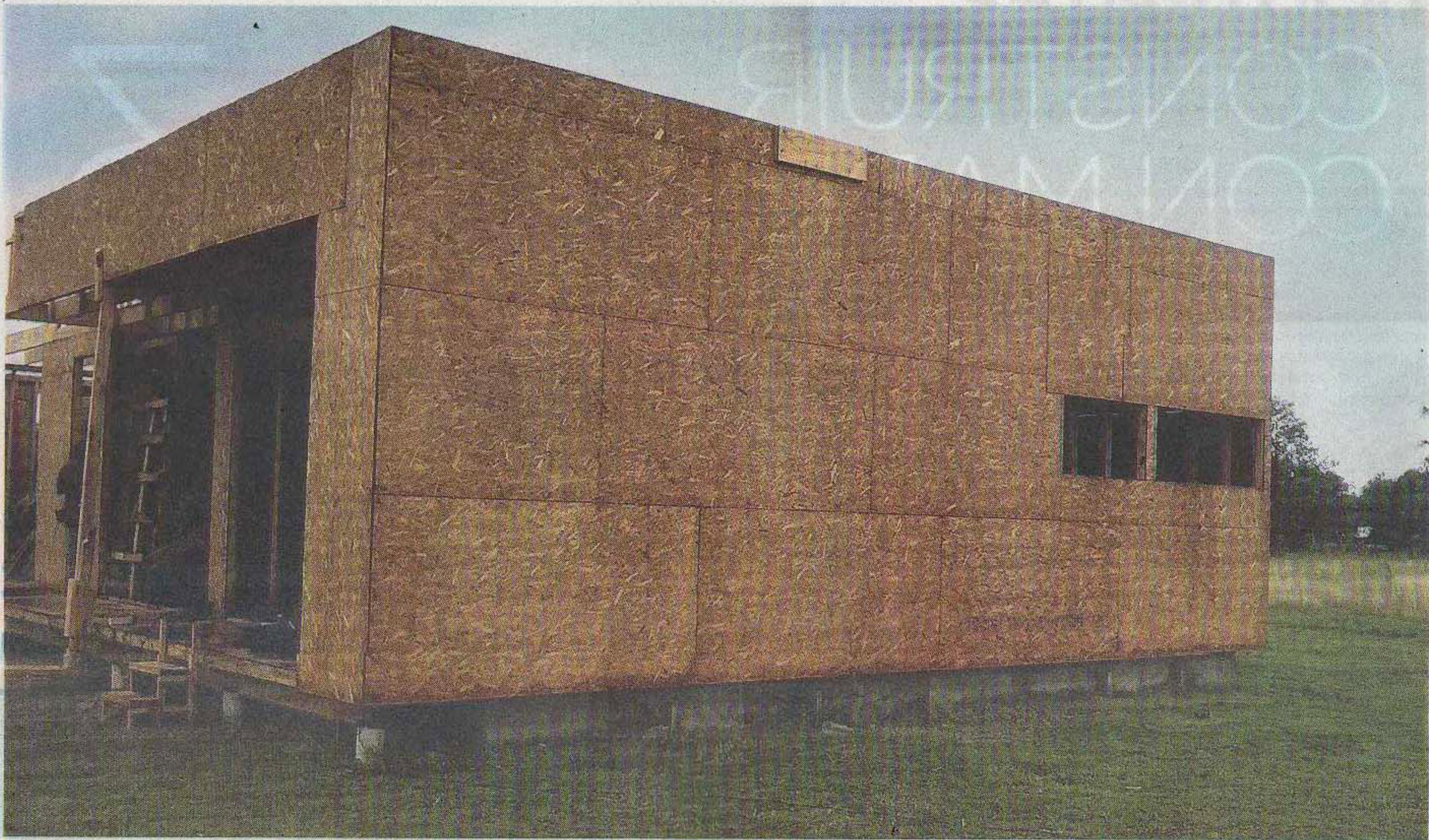
Emplacado. Se aconseja colocar los paneles rigidizadores en sentido horizontal para que queden fijados a la mayor cantidad posible de parantes.
